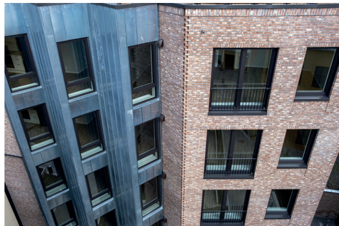
Tegl og stâl er sentrale materialer i fasadene på de nye boligbyggene.
