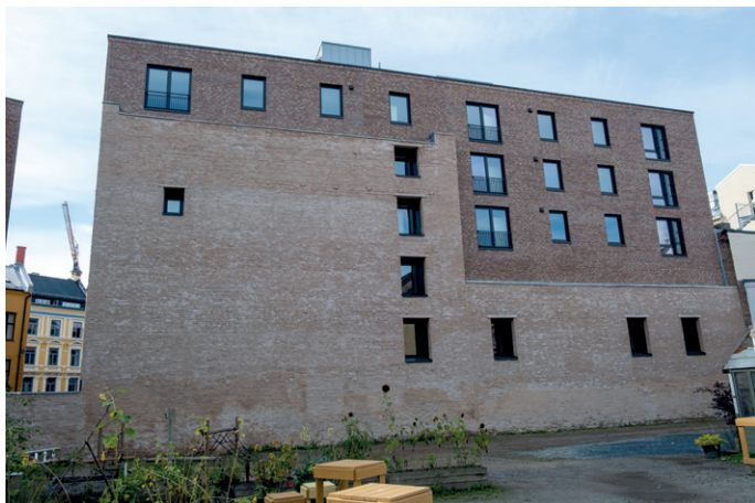
En av de historiske murveggene er bevart og integrert i den nye bebyggelsen
